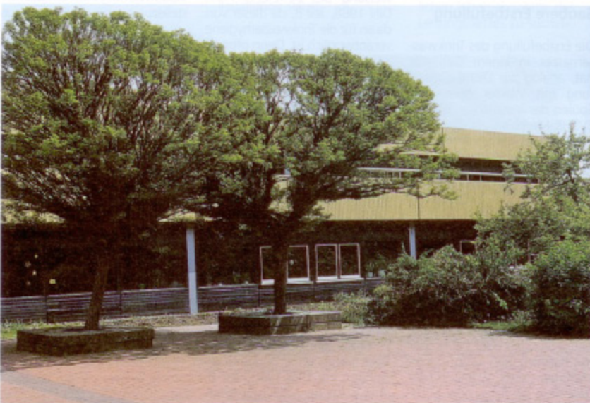
Im Schulzentrum in Bad Gandersheim wurde die Versorgungstechnik auf Vordermann gebracht. Das Ergebnis: Der Heizenergieverbrauch ist heute um mehr als die Hälfte geringer als früher.
