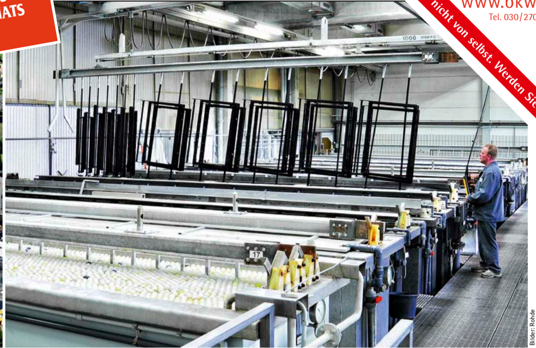
Die Beheizung der Eloxalbäder wurde vom 168 °C heißen Thermoöl auf 110 °C-Heißwasser umgestellt, das ein BHKW liefert
