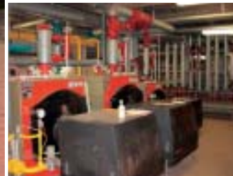
... ersetzt die alten Heizkessel.
